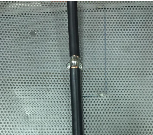
圖 2 U 型金屬配管夾
